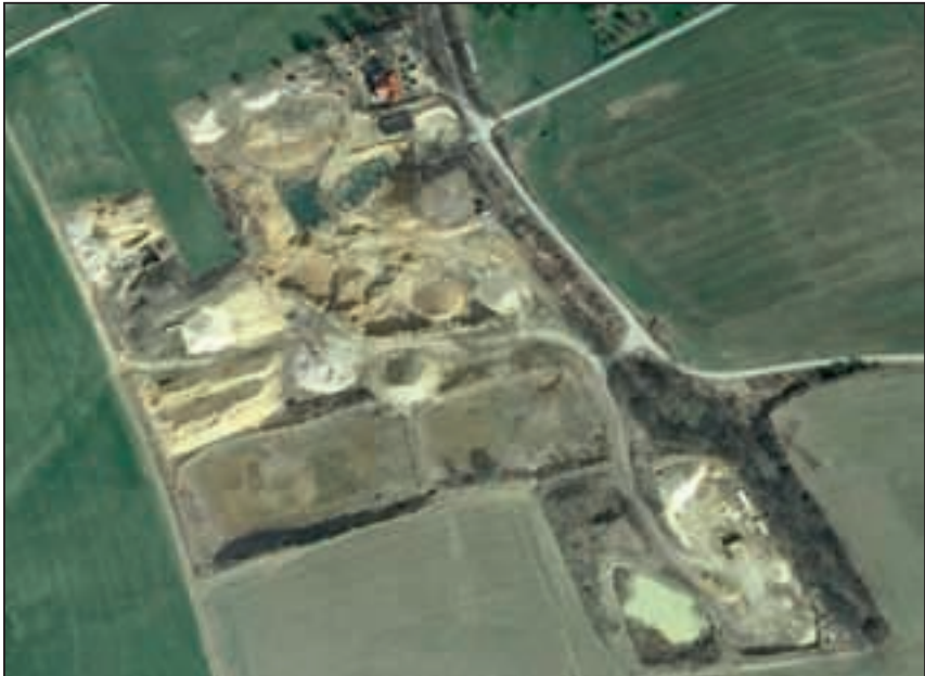
Abb. 1: Luftbild des Kiessandtagebaus Sachswitz, Zustand 2011.
